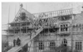
Nach der Übernahme der Klostergebäude werden Renovierungsarbeiten geführt. © Dtsl Archiv
